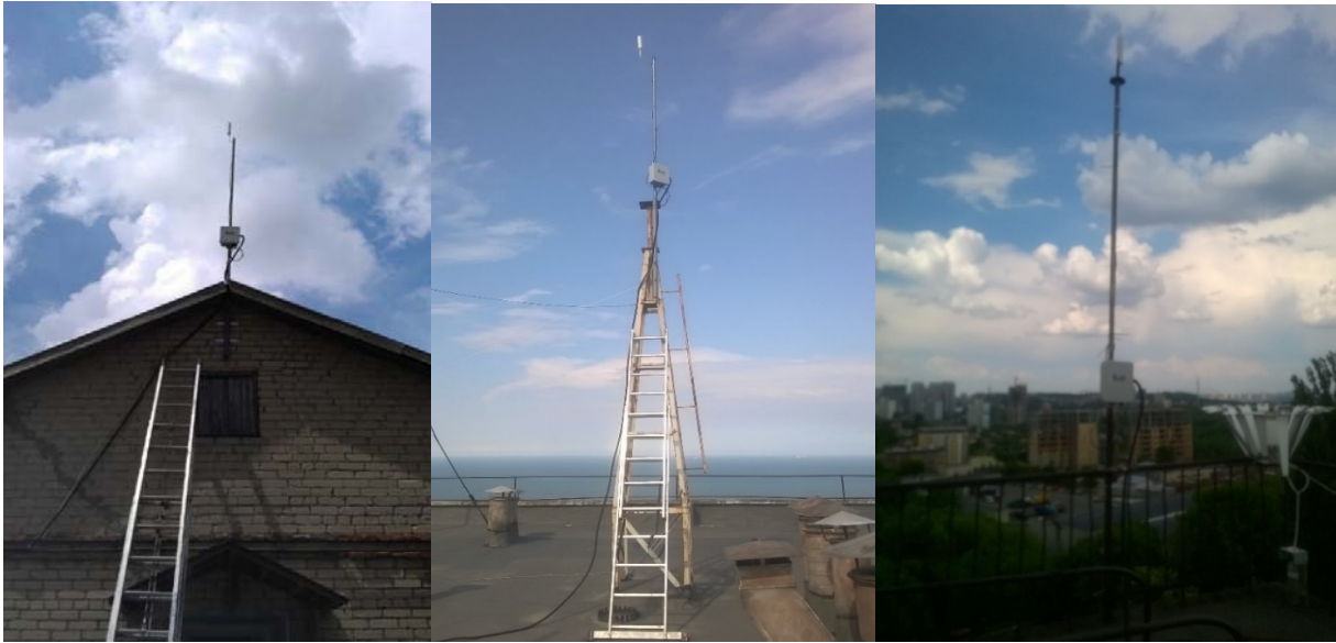
Рис. 5 - Установленные мачты с датчиками грозопеленгации на метеостанции (п. Аскания Нова), в Гидрометцентре Черного и Азовского морей (г. Одесса) и в УкрГМИ (г. Киев)
