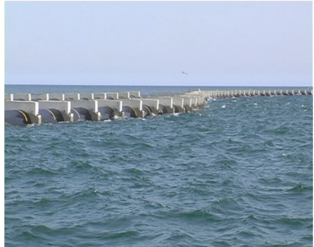
Рис. 2 – Трубопровід морської частини Глибоководного випуску в період будівництва, перед його затопленням на дно Одеської затоки
