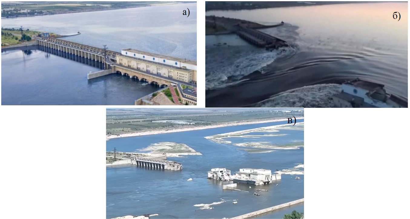
Рис. 2 – Гребля Каховської ГЕС до (а), в момент прориву (б) та після (в) її руйнування Fig. 2 – The dam of the Kakhovka HPP before (a), at the time of breakthrough (b) and after (c) its destruction
