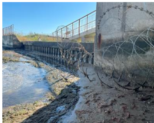
Рис. 3 - Занесення піском каналу і наносотримуючої споруди на ділянках прилеглих до шлюзу-регулятору станом на 27.08.2025 р.
