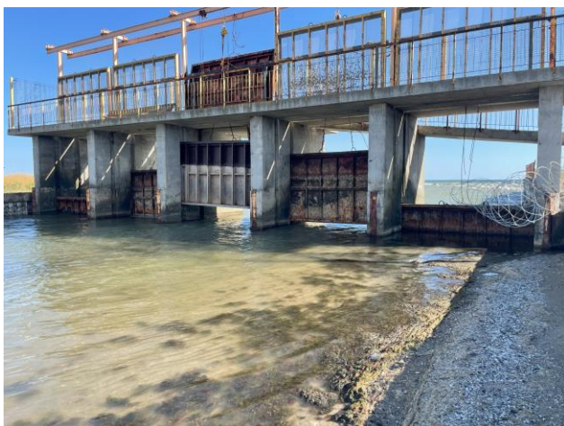
Рис. 3 - Занесення піском каналу і наносотримуючої споруди на ділянках прилеглих до шлюзу-регулятору станом на 27.08.2025 р.
